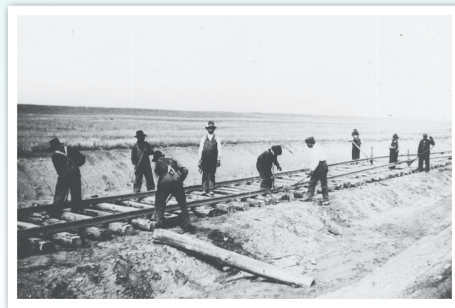
Construction du rail de chemin de fer à Laflèche en 1913
